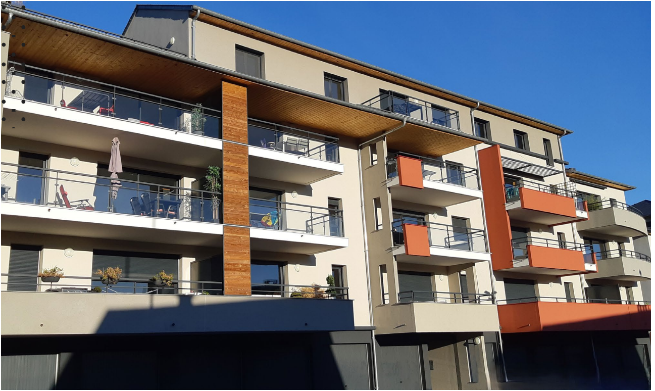
La résidence Les Côteaux des Moutiers, vue depuis la rue
